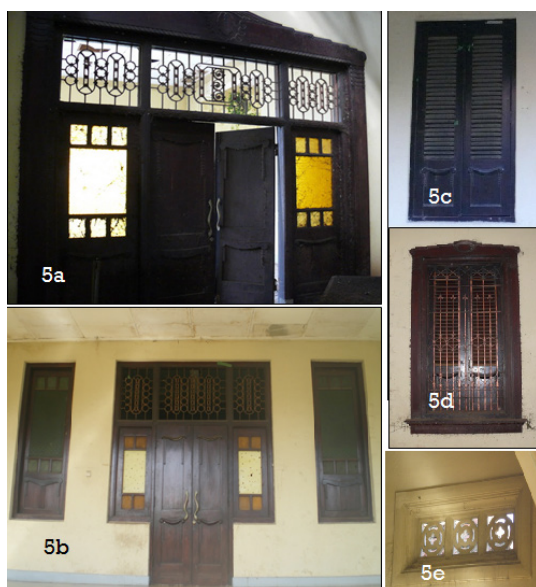
Gambar 5. 5a. Pintu depan di lantai 2; 5b. Pintu belakang Lt 1; 5c. Jendela samping; 5d. Jendela belakang Lt.1; dan 5e. Rooster Lt 1. (Sumber: Dokumen Balai Arkeologi Bandung, 2009).
