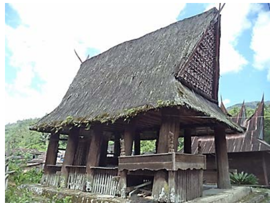
Gambar 6 Sopo Godang di Desa Hutagodang, Kecamatan Ulupungkut, Kabupaten Mandailing Natal (Sumber: Dokumen Nengghih Susilowati, 2016)
