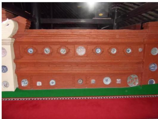
**Gambar 5.** Penempatan keramik pada dinding masjid (Sumber: Dokumen Bauty, 2013).
